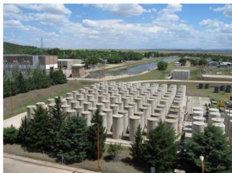
Figure 35 : Entreposage sur le site d'Embalse (Argentine) utilisant le silo béton de la société AECL
