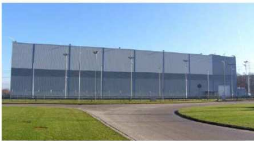
Figure 45 : Photo extérieure d'un bâtiment d'entreposage de type « WTI/GNS »
