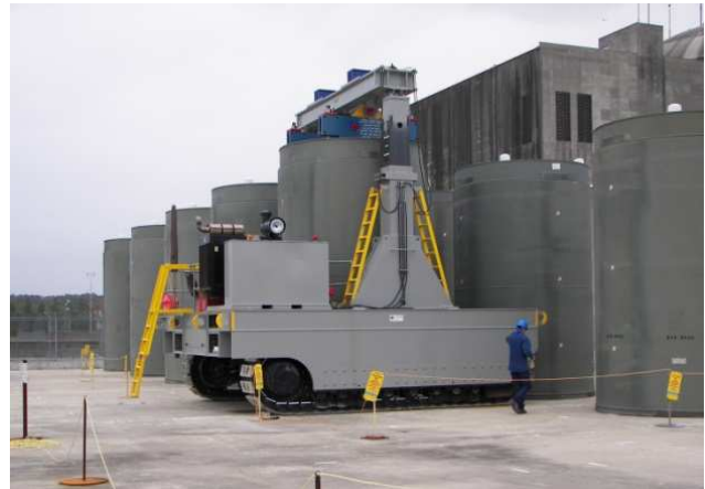
Figure 32 : Photo d'un entreposage utilisant le concept HI STORM 100
