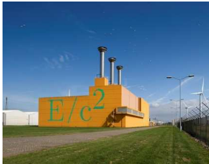
Figure 60 : Photo extérieure de l'installation HABOG (Borsele - Pays-Bas)
