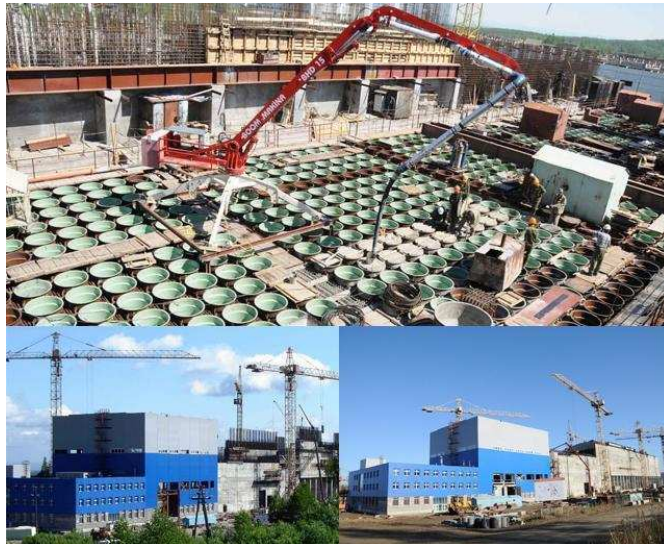
Figure 63 : Photos de la construction des puits et de l'installation centralisée d'entreposage du site de MCC (Zheleznogorsk – Russie)
