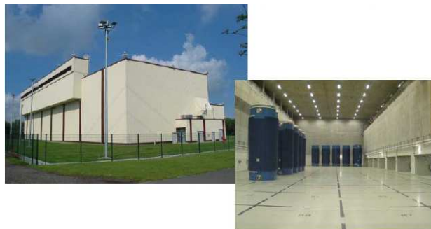
Figure 49 : Photos extérieure et intérieure d'un bâtiment d'entreposage de type « STEAG »
