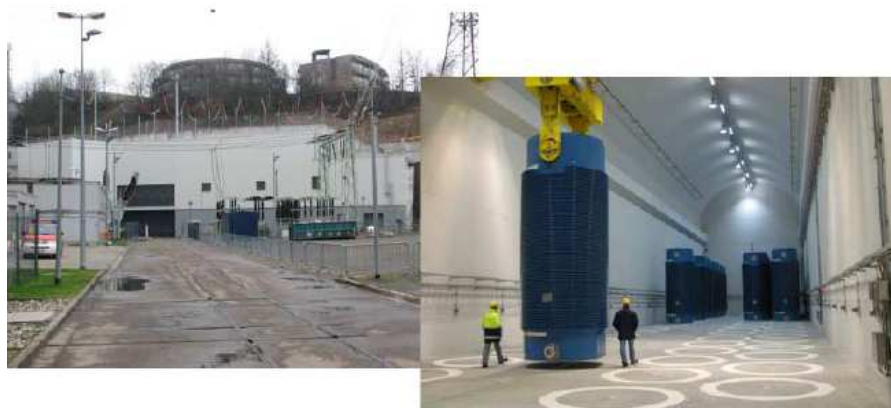
Figure 52 : Photos extérieure et intérieure de l'entreposage en tunnel de Neckarwestheim (Allemagne)
