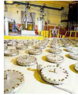
Figure 59 : Photo du sommet des puits d'entreposage de l'installation CASCAD du CEA/Cadarache
