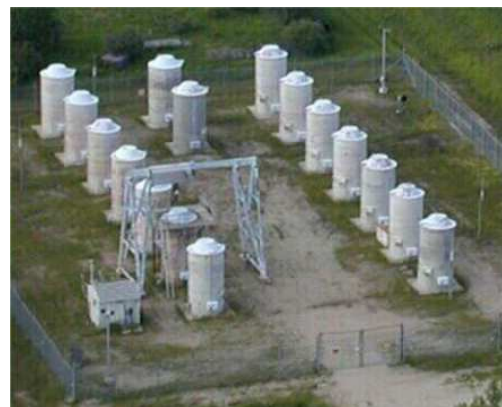
Figure 34 : Entreposage sur le site de Whiteshell (Canada) utilisant le silo béton de la société AECL
