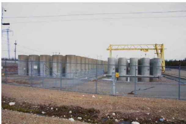
Figure 33 : Entreposage sur le site de Point Lepreau (Canada) utilisant le silo béton de la société AECL
