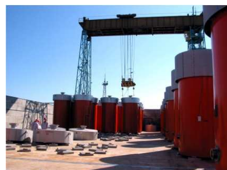
Figure 54 : Entrepôt en emballages CASTOR® sur le site de la centrale d'Ignalina (Lituanie)
