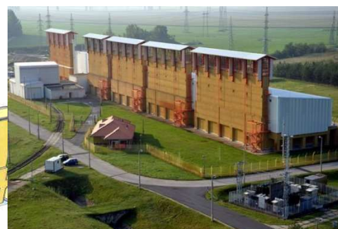
Figure 17 : Photo de l'entreposage MVDS du site nucléaire de Paks (Hongrie)
