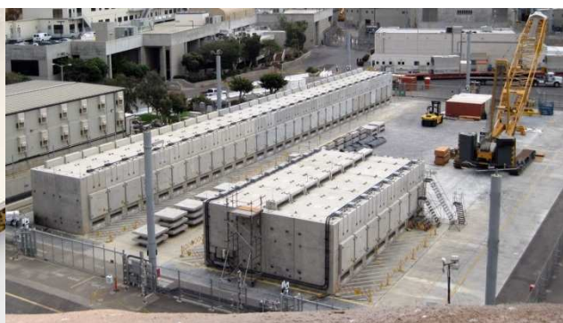
Figure 22 : Photo d'un entreposage de type modules NUHOMS ® sur le site de San Onofre (États-Unis)
