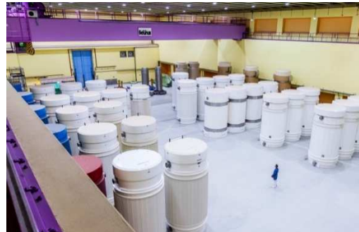
Figure 70 : Photo du hall d'entreposage de l'installation ZWILAG (Suisse)
