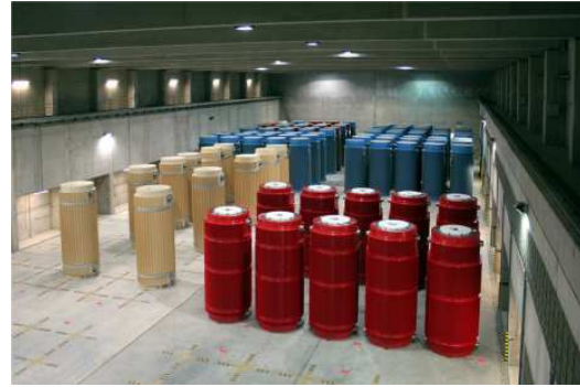
Figure 66 : Photo de l'intérieur de l'entreposage centralisé du site de Gorleben (Allemagne)
