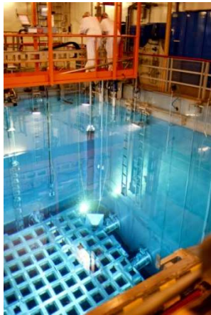
Figure 2 : Photo d'une piscine BK
