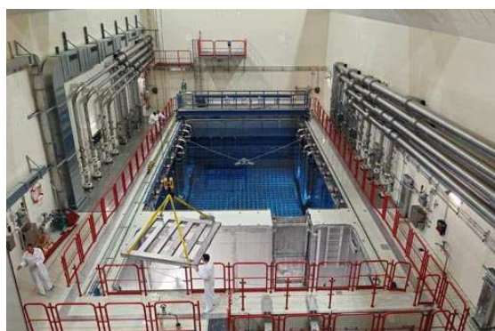
Figure 10 : Photo de la piscine du « bâtiment de stockage des combustibles » de la centrale de Gösgen (Suisse)
