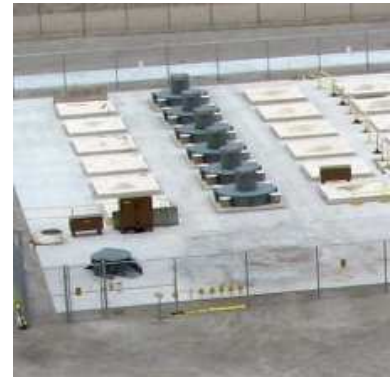
Figure 29 : Entreposage de type HI-STORM UMAX - Centrale de Callaway (États-Unis)
