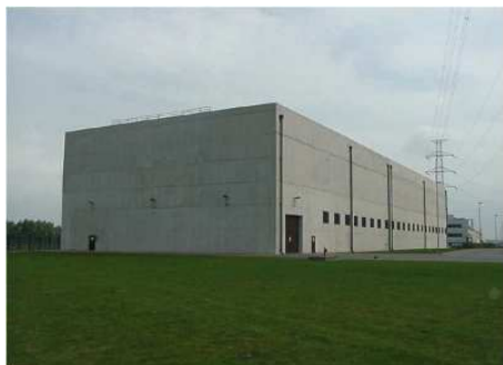
Figure 39 : Photo extérieure du bâtiment d'entreposage à sec du site de Doel (Belgique)
