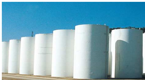
Figure 36 : Entreposage sur le site de Wolsong (Corée du Sud) utilisant le silo béton de la société AECL
