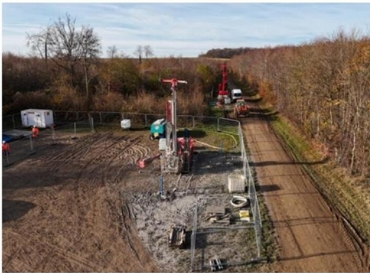
Un forage géotechnique dans la zone puits. Photo Andra
